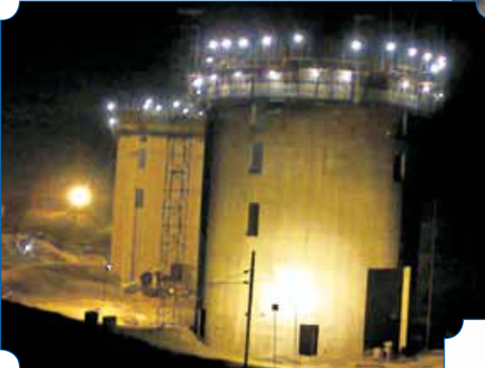
भरतपुर सीएचपी, एमसीएल में प्रत्येक 4000 टन का ट्विन सिलो (निर्माणाधीन)
